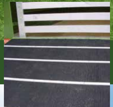
Gummimatte auf Auflauframpe mit Aluminium Steigleisten
